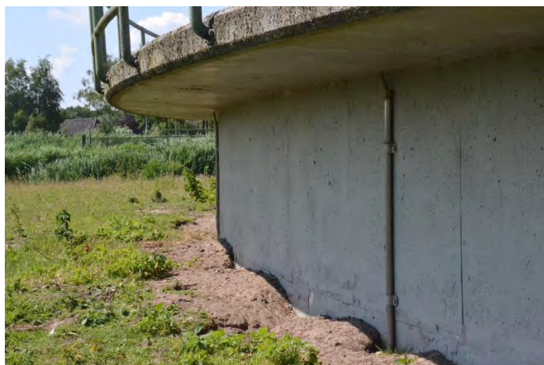
Figuur 5.2 De wanden van de buffertank met konijnenholen.
