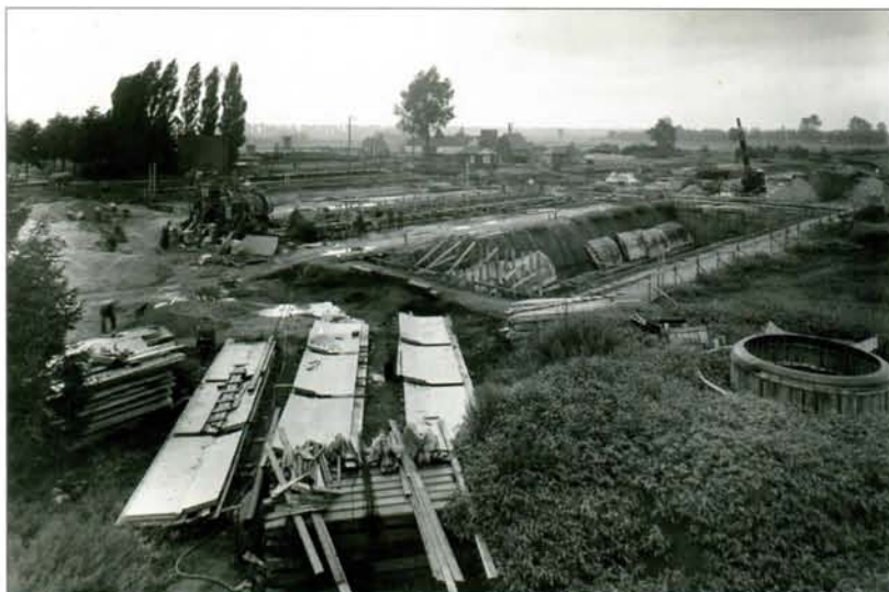
De bouw van de zuiveringsinstallatie in 1936. (Coll. Waterschap De Dommel).
